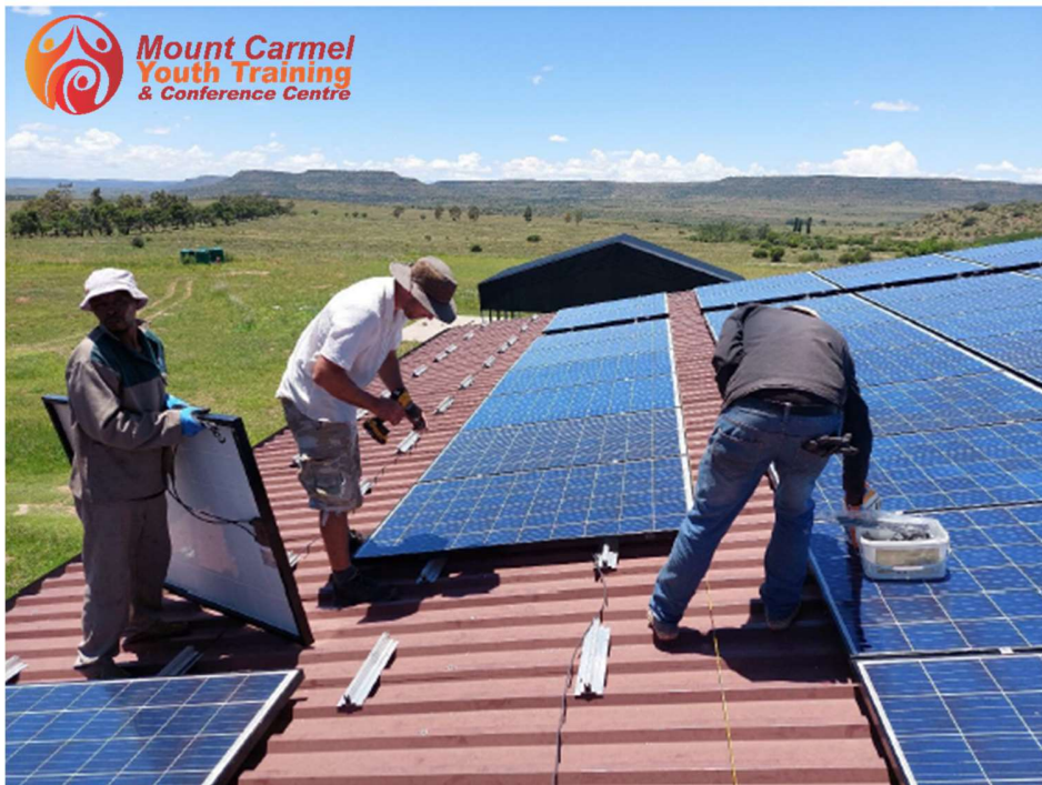
95 PANELEN WERDEN AUF DEM HALLENDACH MONTIERT - JANUAR 2024
